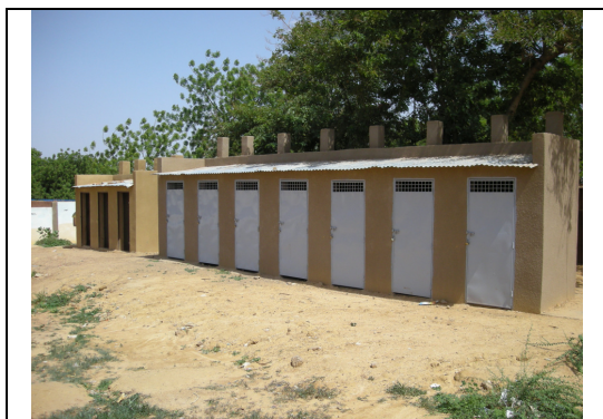
Au premier plan, bloc latrines de 7 cabines nouvellement construit par l'ONEA. Au fond, l'ancien bloc latrines dont les portes métalliques ont été dérobées (école de Bilbalogo).
